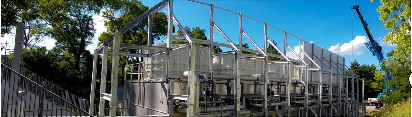
Der Schutz von Menschen vor Schallemissionen im urbanen Bereich wird immer wichtiger. Deswegen wurde im Sommer des Jahres 2016 mit der Firma Cofely und der Firma Wien Energie ein Projekt am neuen Hauptbahnhof in Wien realisiert. Fünf Kühltürme, die für die Klimatisierung des gesamten Hauptbahnhofgeländes zur Verfügung stehen, mussten durch die Errichtung von zwei hintereinander versetzt aufgebauten Schallschutzwänden von den nahegelegenen Anrainern schalltechnisch abgeschottet werden.
