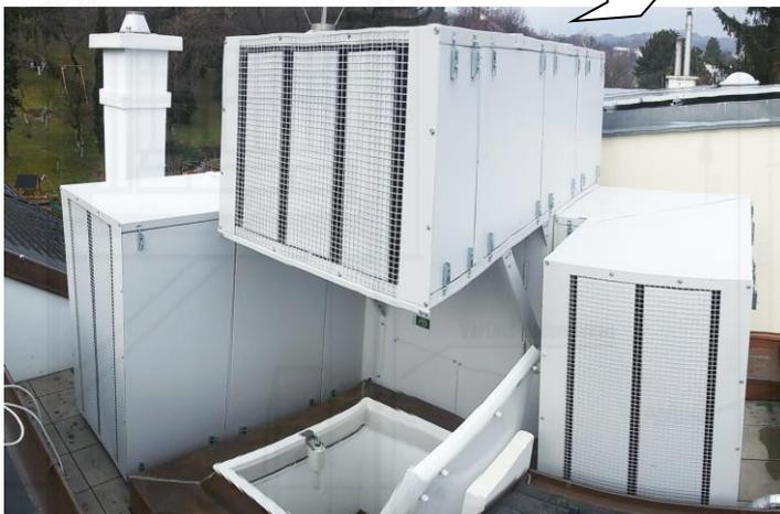
Durch diese Maßnahmen konnte eine Dämmung von  $D_w = 34 \text{ dB(A)}$  erreicht werden.
